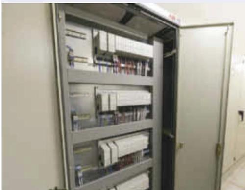
*Das S900-Remote-I/O-System stellt eigensichere Ein- und Ausgangsmodule zur Verfügung, die für den Anschluss der Feldsignale erforderlich sind*
